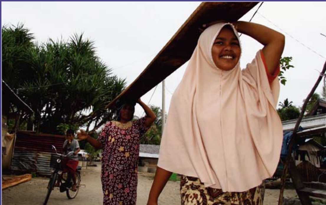
Восстановительные работы после разрушительной волны цунами в Банда Асах, Индонезия. Фото@ ООН-ХАБИТАТ
